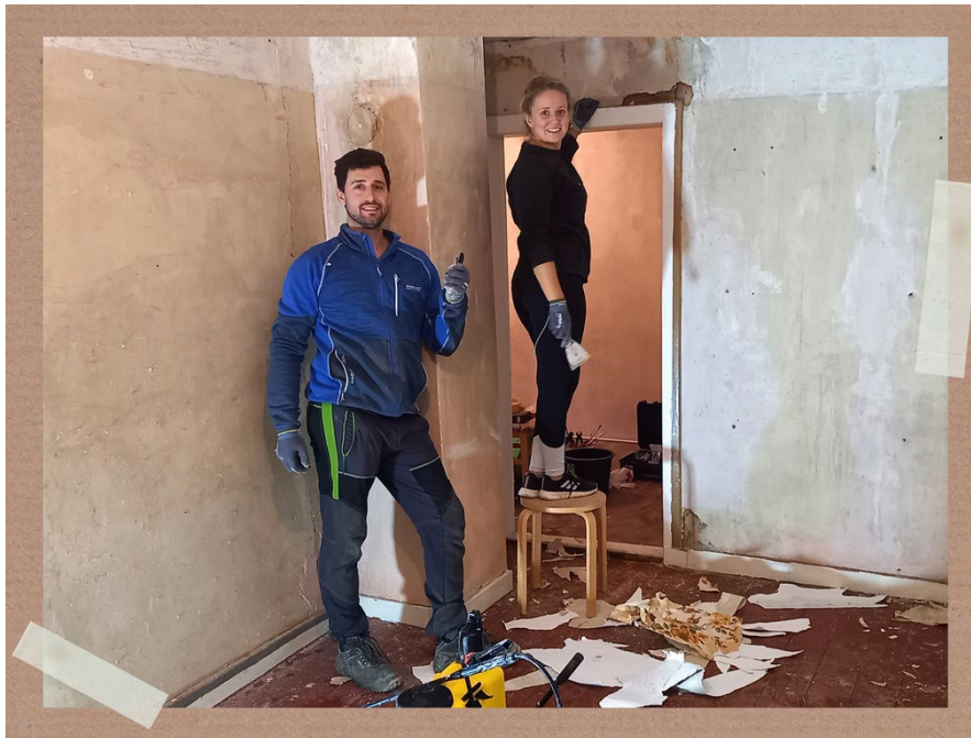
Renovierung Hausmeister Haus
